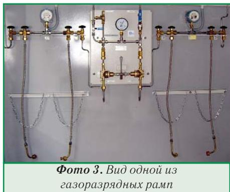
Фото 3. Вид одной из газоразрядных рамп
