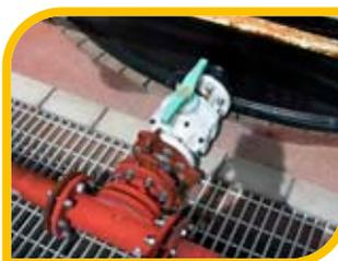
PVDF кран SAFI устанавливают вместо футерованного чугуна мембранного крана в нижней части резервуара для хранения 98%-ого раствора серной кислоты.
